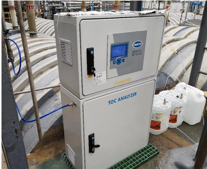
图 1 B7000i TOC 在线分析仪现场安装图
